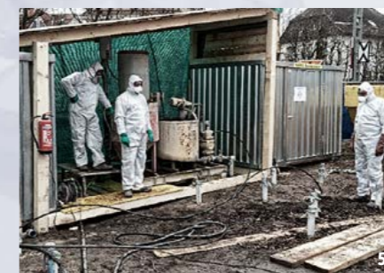
3 Einführung des Verpressschlauchs in das ISCORAPID®-Ventilrohr
